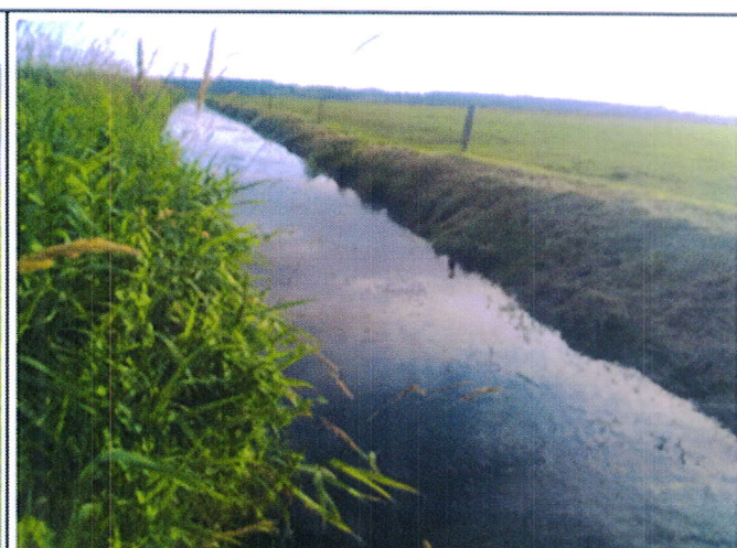
Photo n°2 : vue début des travaux du ruisseau des Frémis
