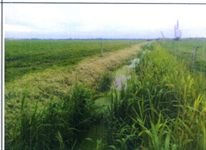
Photo n°4 : vue de la section 3 des travaux du ruisseau des Frémis
