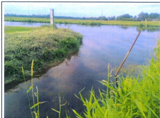
Photo n°1 : vue aval des travaux du ruisseau des Frémis
